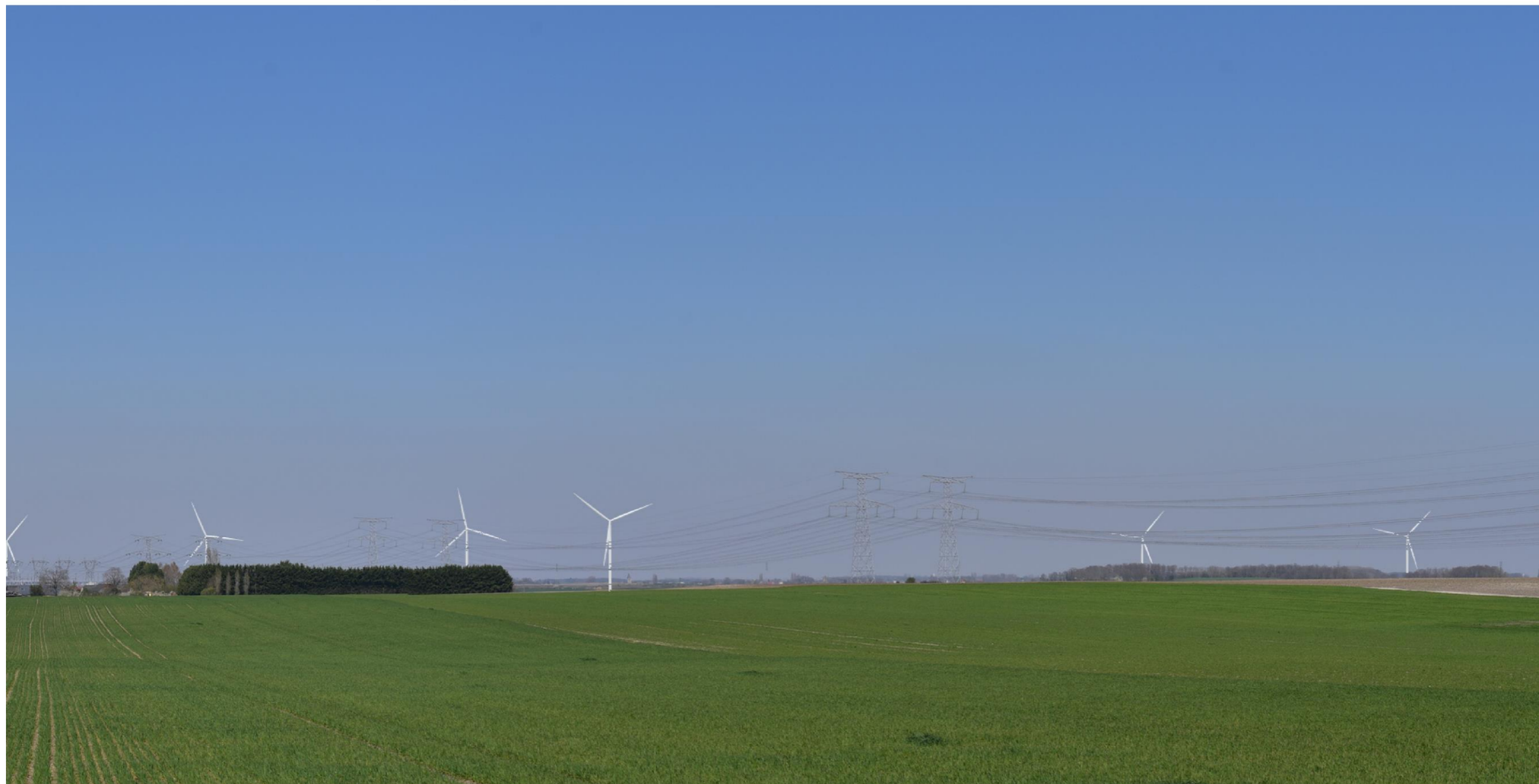
Etat initial vue 1 - Vue réelle - Pour restituer le réalisme du photomontage, observez-le à une distance d'environ 55cm au format A3
